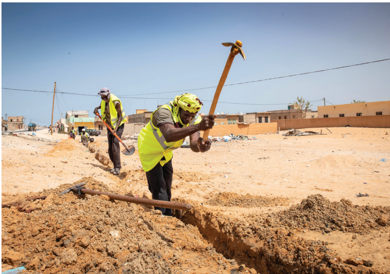
Plus de 200 km de réseaux d'eau posés.
