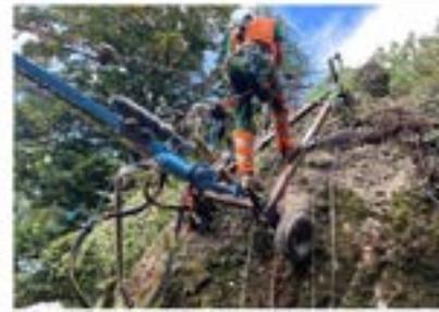
Les lignes métalliques permettent d'ancrer les masses rocheuses au sous-sol.
